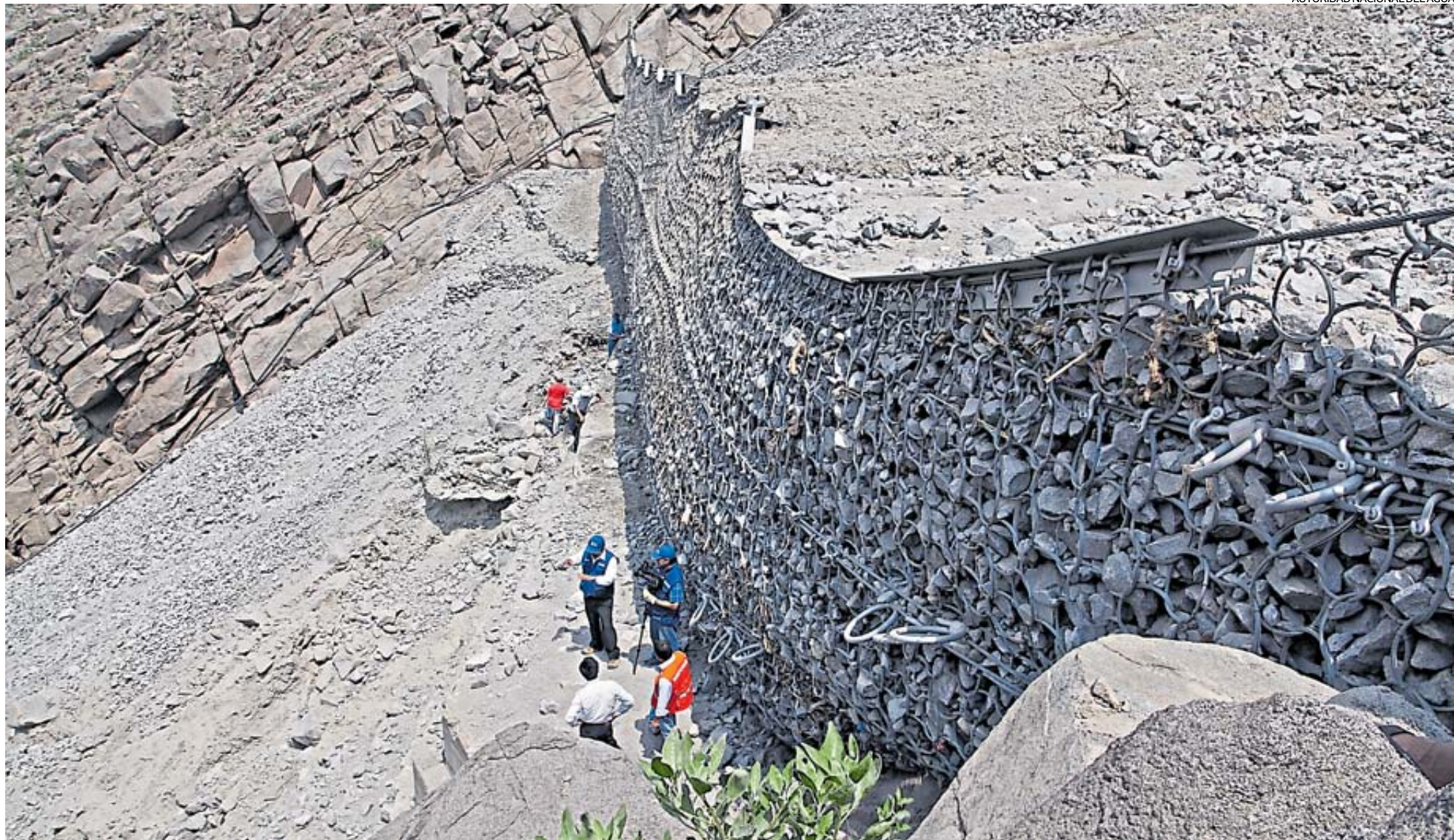
La geomalla más grande de Latinoamérica está instalada en la quebrada Carossio. Mide 6 metros de alto y tiene 62 metros de largo en su parte más extensa. Esta fue una de las que más material logró contener.
