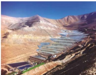
La función principal del Pad es contener el mineral para su procesamiento mediante la lixiviación. Para ello extrae uno o varios solutos de un sólido.
